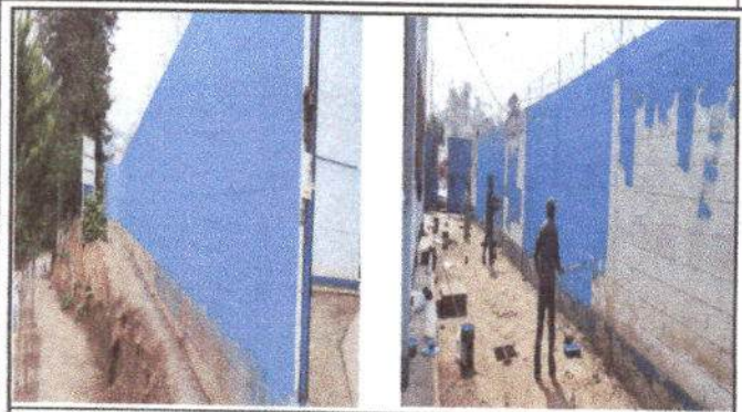
Foto 1: Pintura en muros exteriores e interiores.
