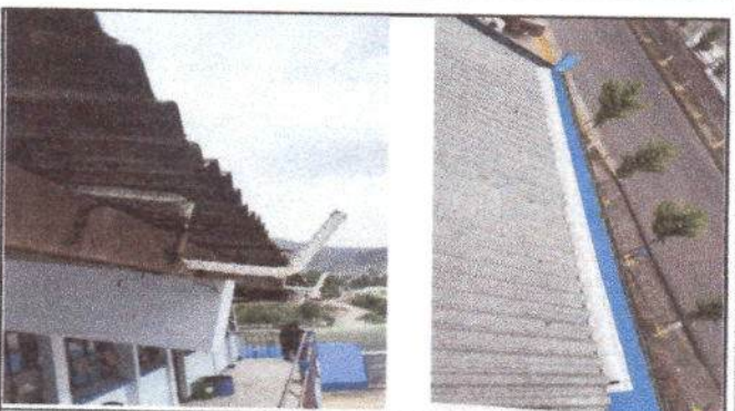
Foto 4: Sustitución de canales enfrente y atrás del edificio, segundo nivel.
